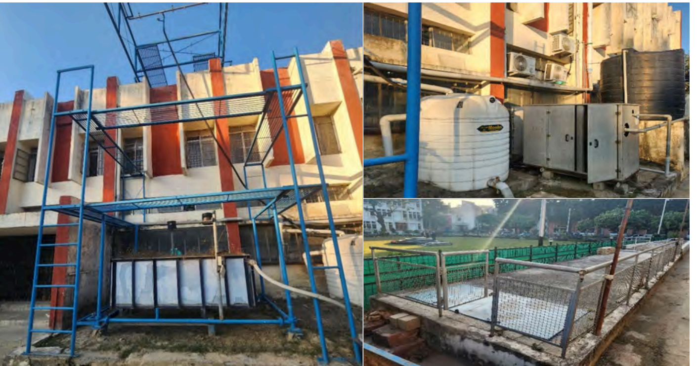
चित्र 1: आईआईटी रुड़की में स्थापित रूफटॉपवर्षा जल संचयन प्रणाली।
